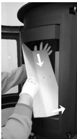
7. Drücken Sie immer die Stahl-Umlenkplatte nach oben. Fassen Sie die Beton-Seitenplatte für die untere Kante in Richtung in die Mitte an. Ziehen Sie die Platte durch die Türöffnung diagonal heraus. Auf beiden Seiten.
